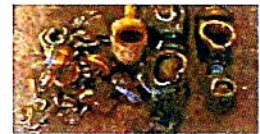
解体後 砲金バルブ
